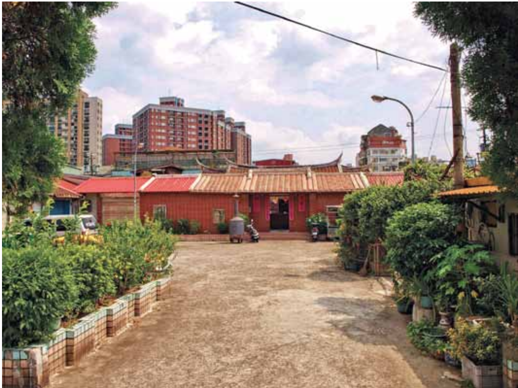
■ 板橋湳仔江璞亭公祖祠堂正立面景觀
