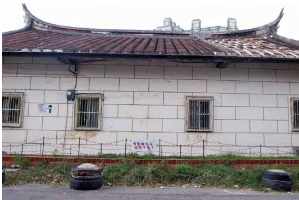
■ 湳仔江氏公廳牆壁原為夯土所製的春泥牆
